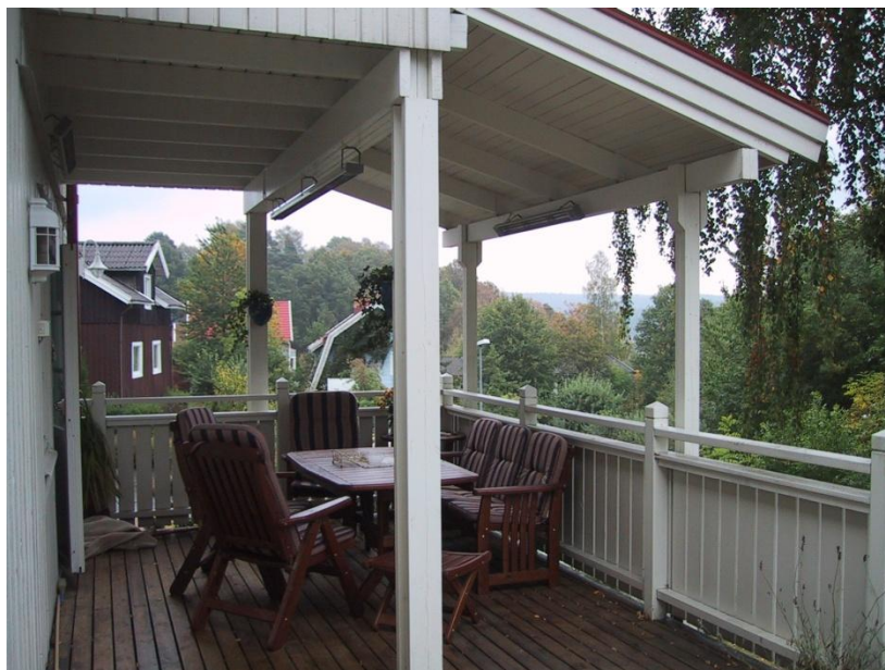
Монтаж на высоте 2,5 м
